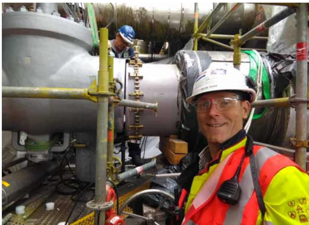
Stolzer Kunde beim Einbau der DN900 QUADAX®-Top Entry.
