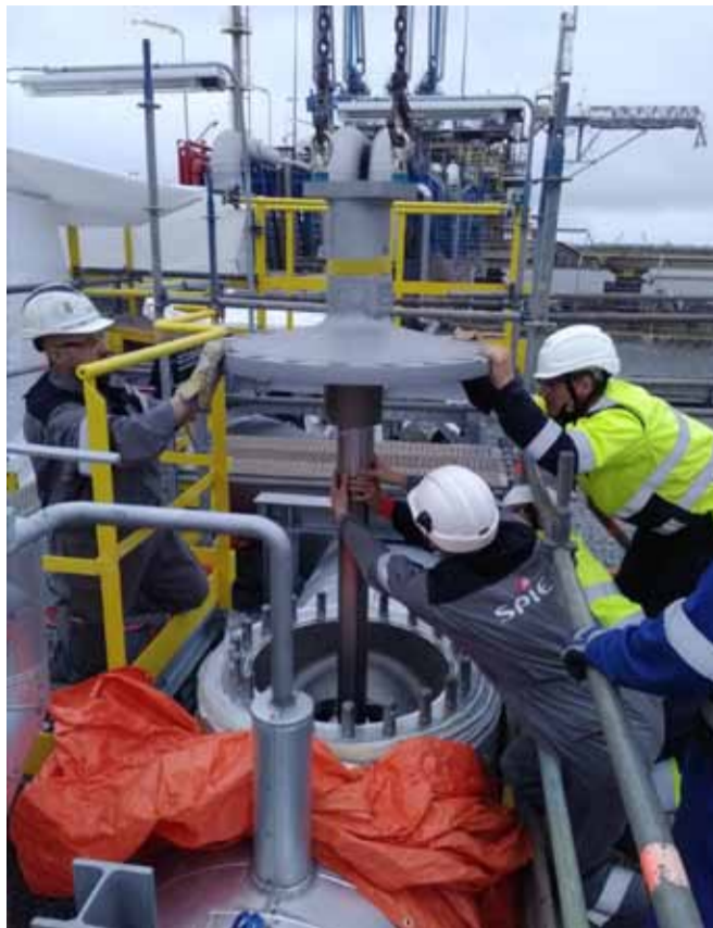
Montageteam beim erfolgreichen Einbau der DN900 QUADAX®-Top Entry.
